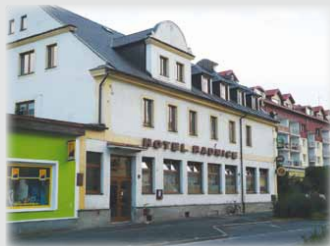
Hotel Radnice od Klatovské ulice dříve a dnes. Na starší fotografii ještě bez přístavby bývalého kina.
